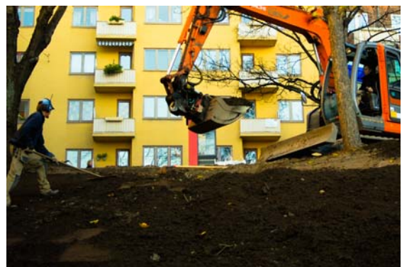
Flytting av jordmasser er virksomhet som omfattes av aktsomhetsplikten. Foto: Agnes Lyché Melvær.
