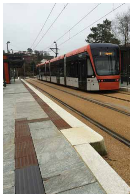
Farefelt skal følge hele kanten langs perrongen på stasjoner for skinnegående trafikk. Bybanen I Bergen. Arkitekt/Landskapsarkitekt: Arkitektgruppen Cubus.
