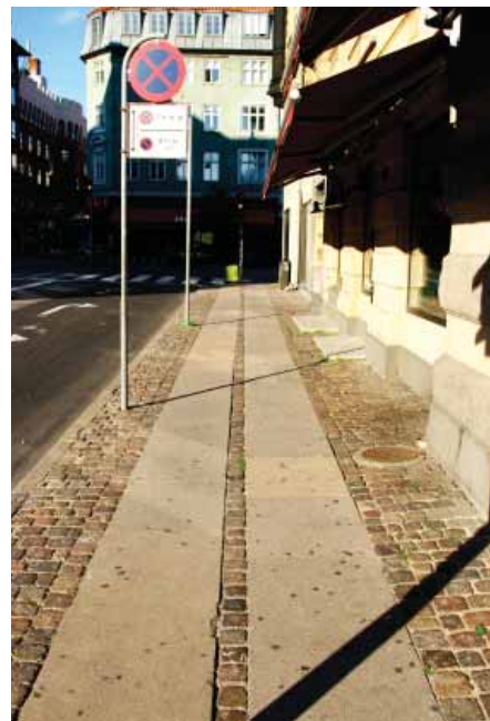
Soner på fortau. "Københavnstandard" med heller i gangsonen og gatestein i møblerings- og veggsonen.
