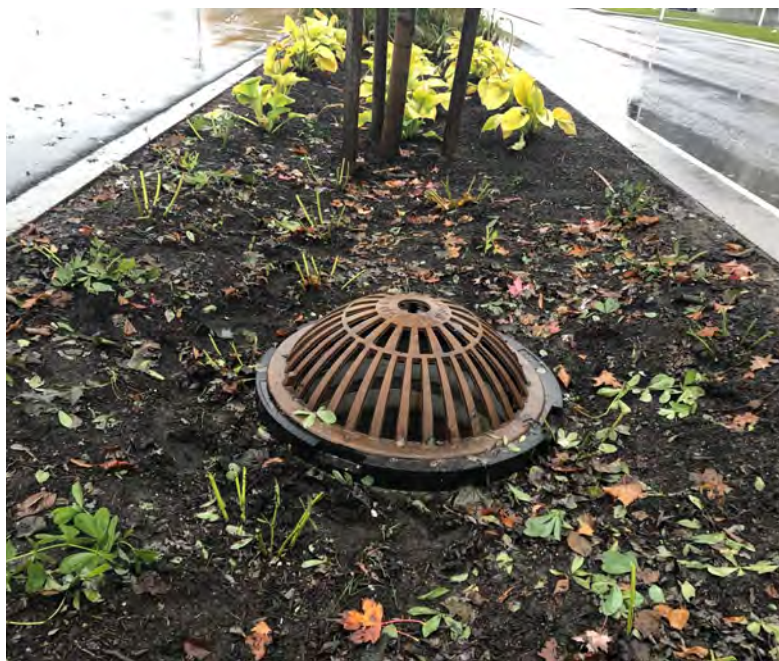
FIGUR 7-23 Blågrønn grøft og regnbed, Bjørnstjerne Bjørnsons gate i Drammen
