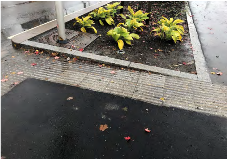
FIGUR 7-19 Kantstein med regnbed Bjørnstjerne Bjørnsons gate i Drammen
