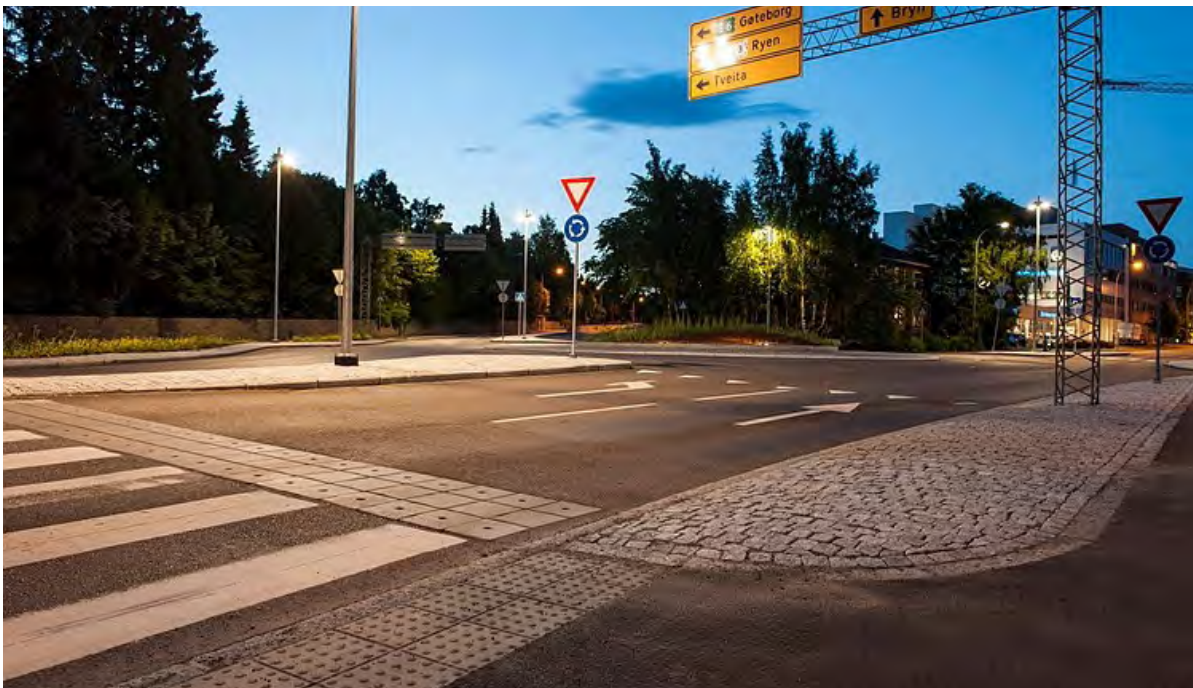
FIGUR 4-2 Overgang i smågatestein og asfalt fungerer godt som naturlig ledelinje.
