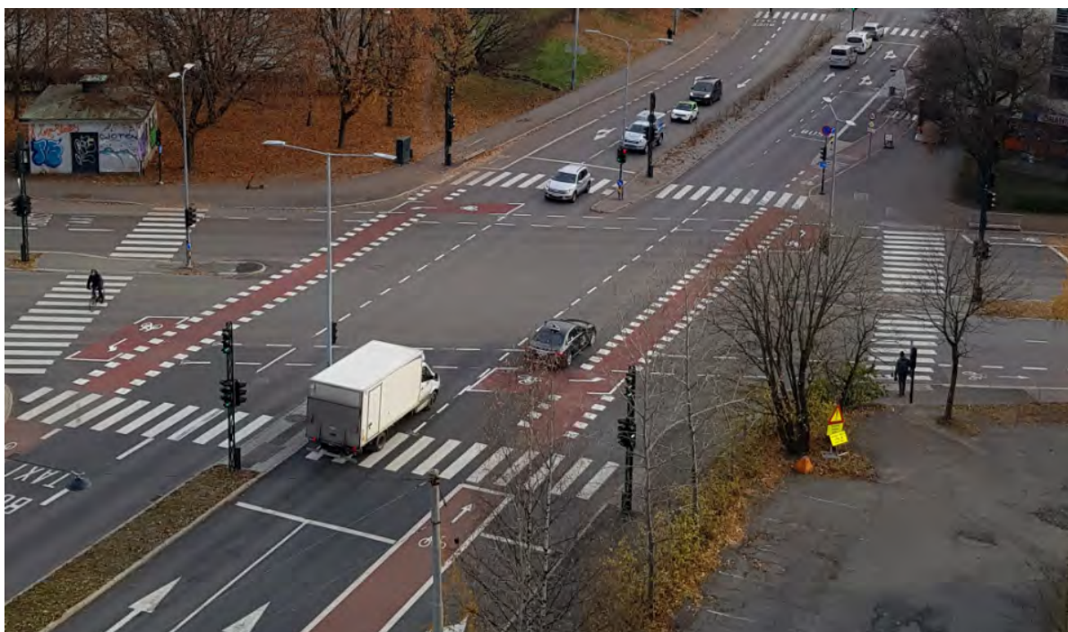
FIGUR 4-37 Løsning med stor venstresving i kryss på Lovisenberg
