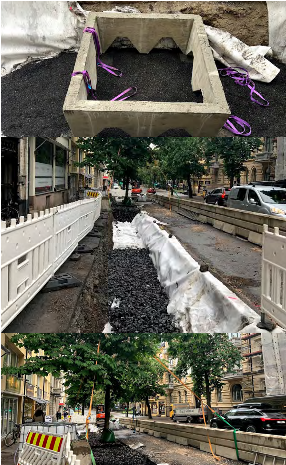
FIGUR 7-17 Eksempel på rotvennlig fortsterkningslag og biokull anlagt i Bygdøy Allé
