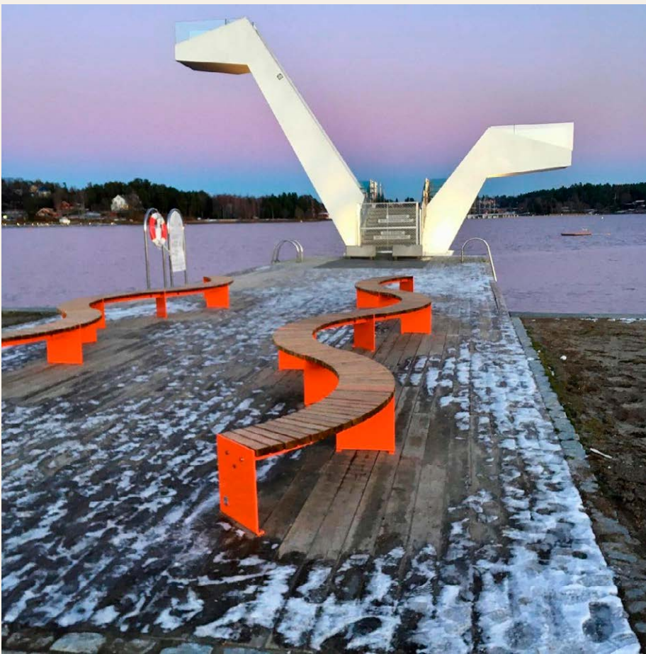
Nye Kadettangen i Sandvika, bar bakke landskapsarkitekter. Oppdragsgiver: Bærum kommune. Foto: Ragnhild Brudevik.
