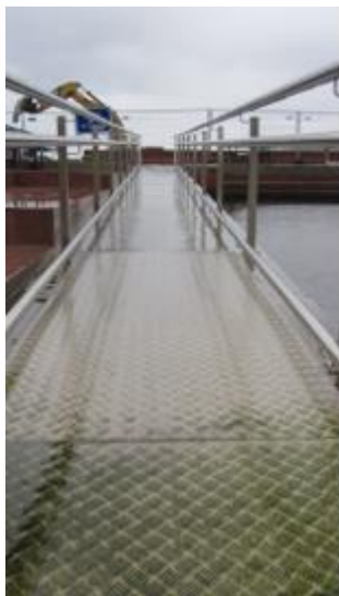
Universelt utforma baderampe på Bystranda med sklisikre dekkplater (dekkplater for fiskebåter). Foto: Helmer Espeland
