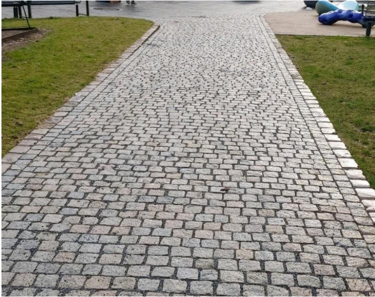
Referanse Kvalitet på gangvei med gatesteinsdekke. Torvet 2019. Foto Helmer Espeland.
