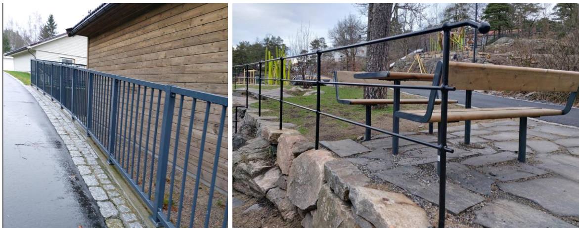
Eksempler på utførelse, hhv. klatresikkert rekkverk (Torridal gravplass) og «Sørlandsrekkverk» Peisestua på Odderøya. Foto Helmer Espeland
