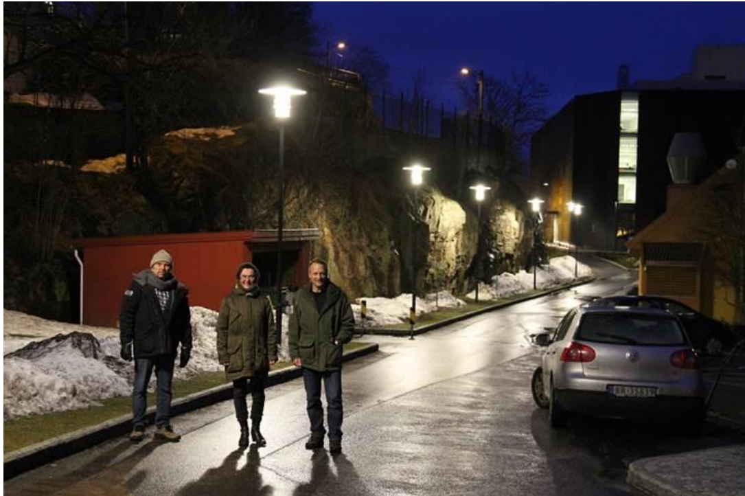
Belysning av gangvei. God ansiktsgjenkjenning og godt lys til sideterrang og smug. Gangveien til Kilden. Foto: Svein Tybakken, Kristiansand kommune.
