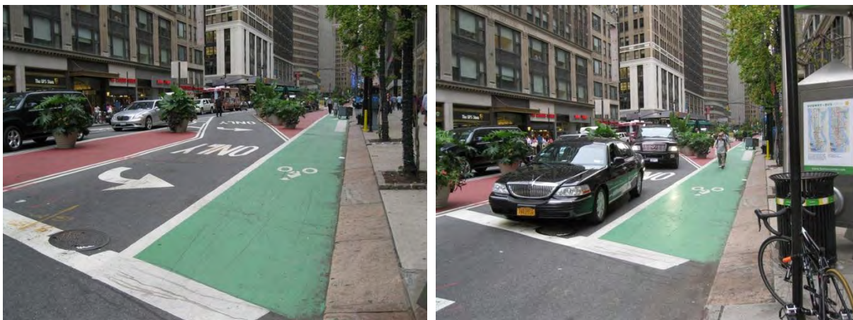
Figur 2.14: Ekstra svingfelt for biler før kryss skaper et mer lesbart kryss og opprettholder bilkapasiteten, Broadway
