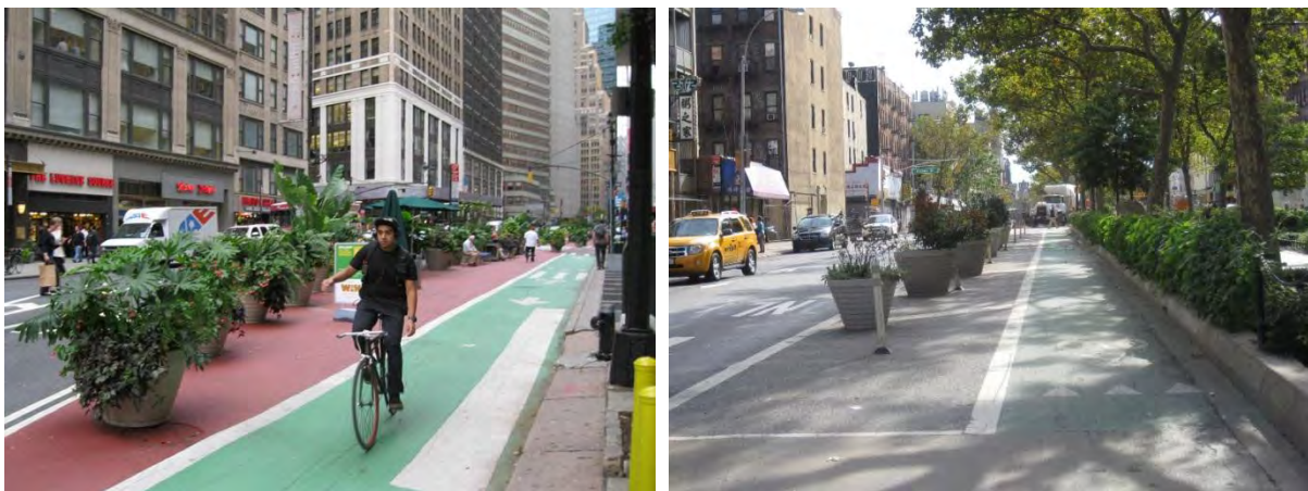
Figur 2.3: Ulike former for envegs beskyttet sykkelveg, til venstre Broadway og First Avenue til høyre
