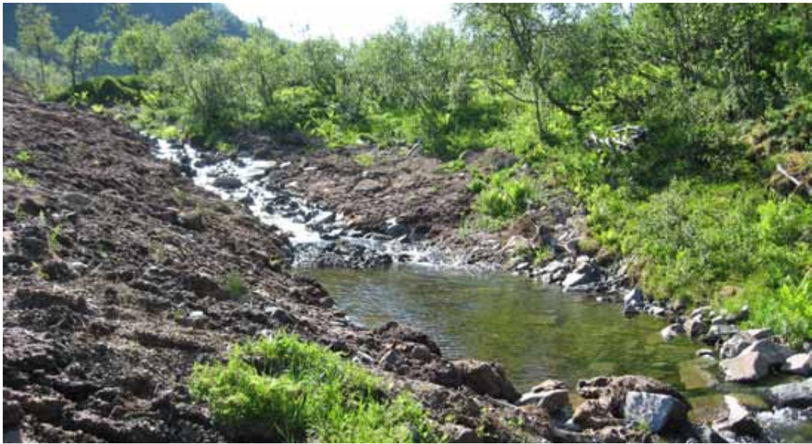
Figur 29: Den nybygde bekken er hevet flere meter opp i forhold til bekkens gamle løp. En dyktig maskinfører har fått til en fin overgang mot omkringliggende terreng. Foto: Kongsbakk
