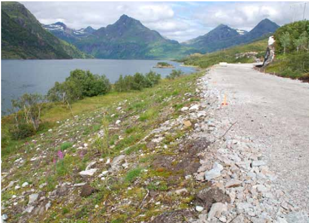
Figur 39A,B: Jorden ble tilbakelagt høsten 2004. I juni 2005 var spiringen godt i gang, men hovedinntrykket var brunt. Juli 2007 var vegkanten grønn. Auserstraumen, Øksfjorden. Foto: Skrindo
