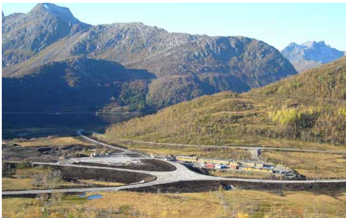
Figur 19: I Gullesfjordbotn er terrenget betydelig ombygd. Foto: Johansen
