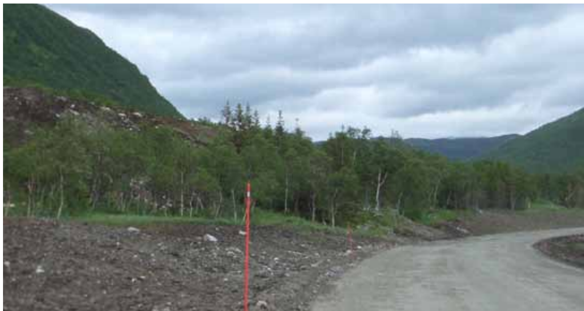
Figur 11: I Sør dalen ble to rasvoller plassert slik at det skulle være mulig å beholde vegetasjon både mellom vegen og vollene, og mellom de to vollene. Skogbeltene var avsatt som botområde i rigg- og marksikringsplanen. Den bakerste vollen skimtes så vidt til venstre i bildet. Foto: Kongsbakk
