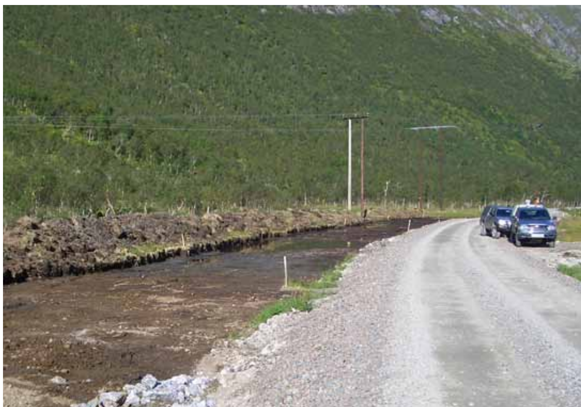
Figur 14: Anleggsvegen fulgte traseen for permanent veg. Den ble bygget rett på torvlaget ved bruk av armeringsprodukter og et tynt lag overdekning. På bildet er forbreddelsene for bygging av permanent veg i gang. Vekstmassene er skavet av. Torv av stor mektighet ble trauet ut og kjørt på mellomlager. Foto: Kongsbakk
