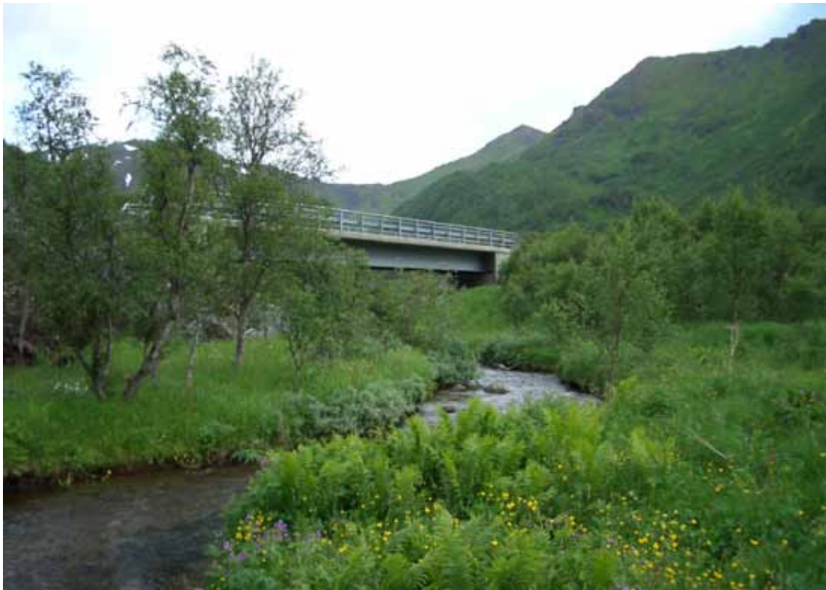
Figur 17A: En sideveis flytting av veglinja på Storå gjorde at man helt unngikk ombygging av elveløpet og kunne bevare intakt terreng helt inntil ny bru. Foto: Kongsbakk
