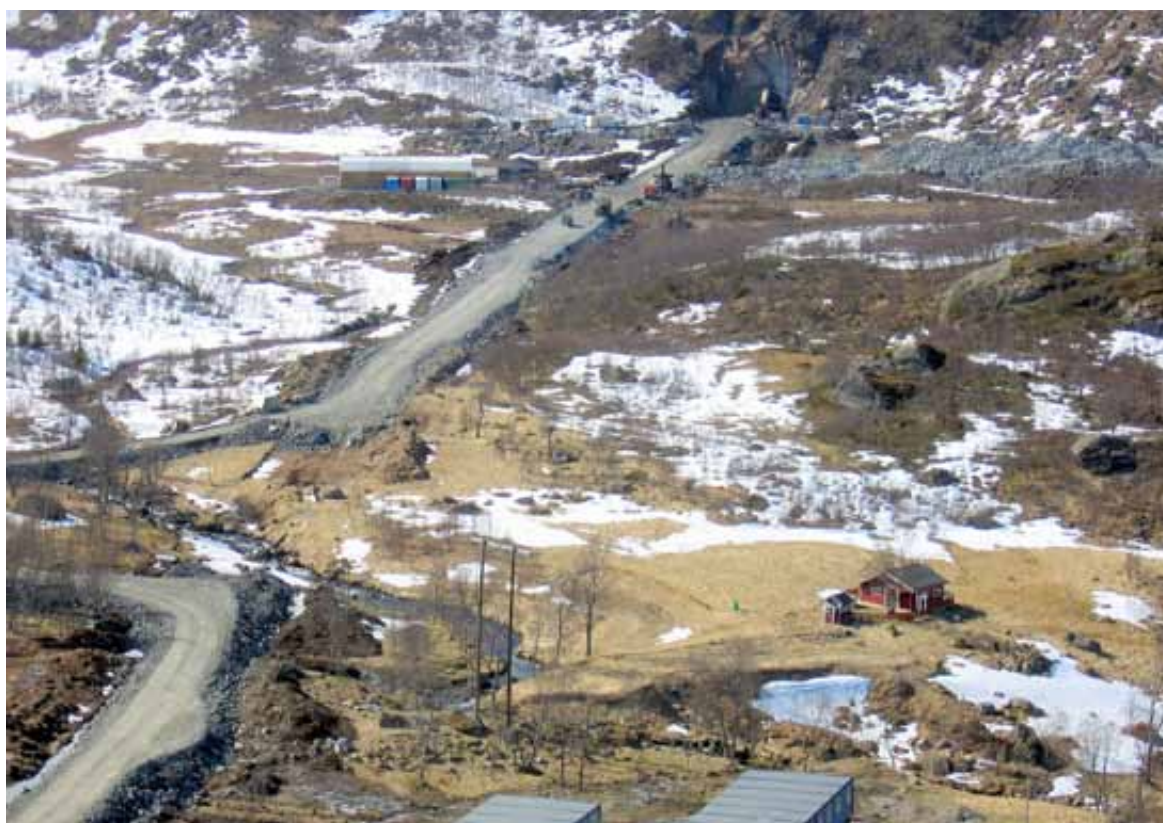
Figur 12: På Storå ble midlertidig anleggsveg lagt 35 meter sør for vegen. Rigg- og marksikringsplanen satte inngrepsgrenser og et botområde slik at bruas nærrområde kunne beholdes inntakt. Foto: Eliassen
