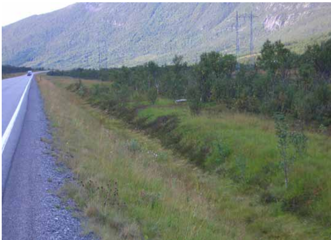
Figur 28: Lyngen trives på den tørre rabben ned mot grøfta. Der sideterrenget er slavisk formet etter vegmodellen vil man for alltid se skillet mellom veginngrepet og omkringliggende terreng jamfør figur 16. Foto: Kongsbakk
