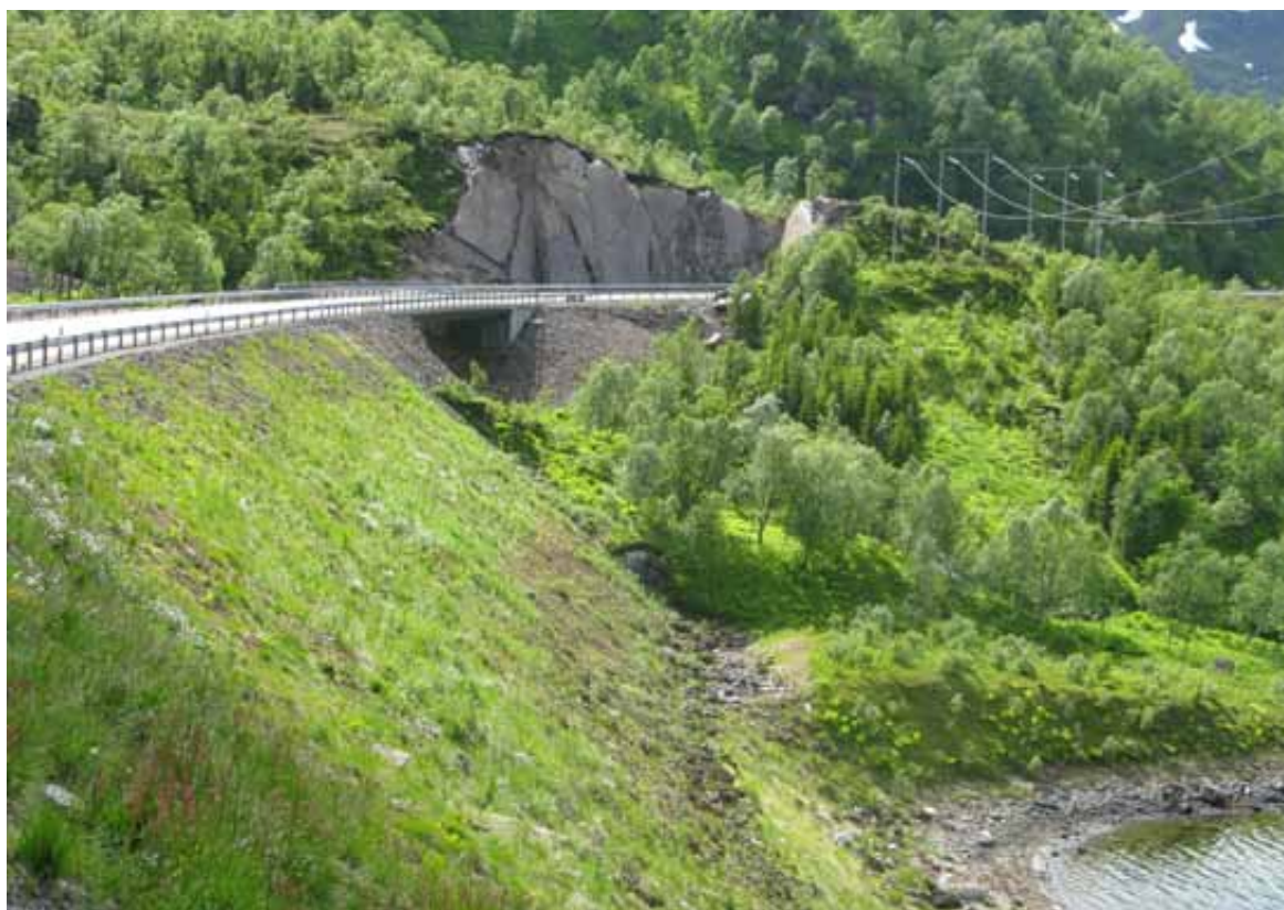
Figur 37: Den bratteste revegeterte steinfyllingen på Lofast har en helning på 37,5 grader. Skråningen i Svartskarvika bærer ikke tegn til skader. Her fotografert sommeren 2009. Foto: Kongsbakk
