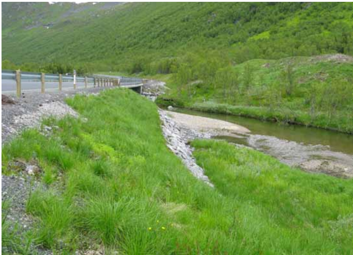
Figur 51: Inntrykket av de to rasvollene er dempet ned ved å orientere dem langs dalsiden istedenfor langs vegen, og ved å bevare skogbelter mellom vollene og vegen. Det koster omtanke, ikke mer penger. Foto: Kongsbakk
