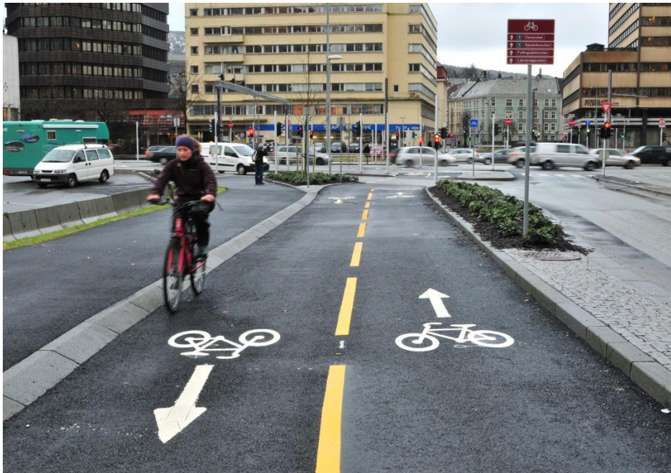
Figur 18: Skilting av sykkelrute langs sykkelveg med fortau i Bergen sentrum. Foto: Reidun Instanes
