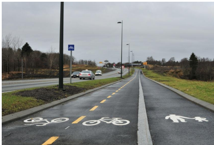
Figur 13: Sykkelveg med fortau, Fleslandveien Bergen, Foto: Reidun Instanes Statens vegvesen
