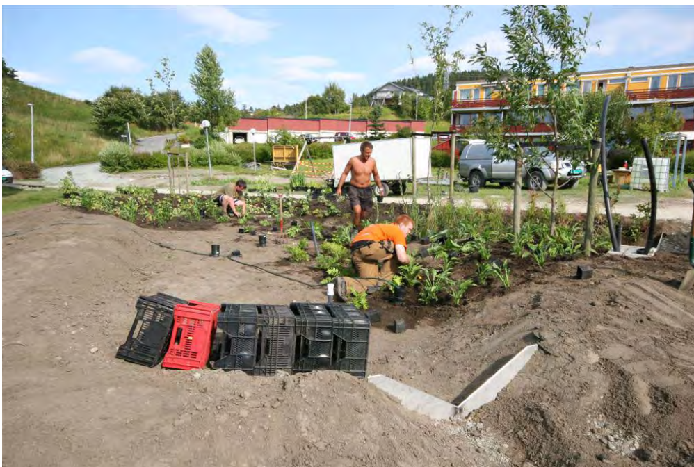
Figur 47. Planting av regnbed anleggsåret. Vanning og ugrasbekjempelse må til om etableringen skal gå godt (foto: AE).
