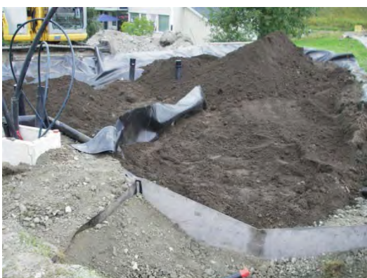
Figur 43. Montering av V-overløp inn og ut av regnbedet for å måle vannføring inn og eventuelle overløp. Deretter ble filtermasse bestående av kompostblandet sandjord fylt inn.
