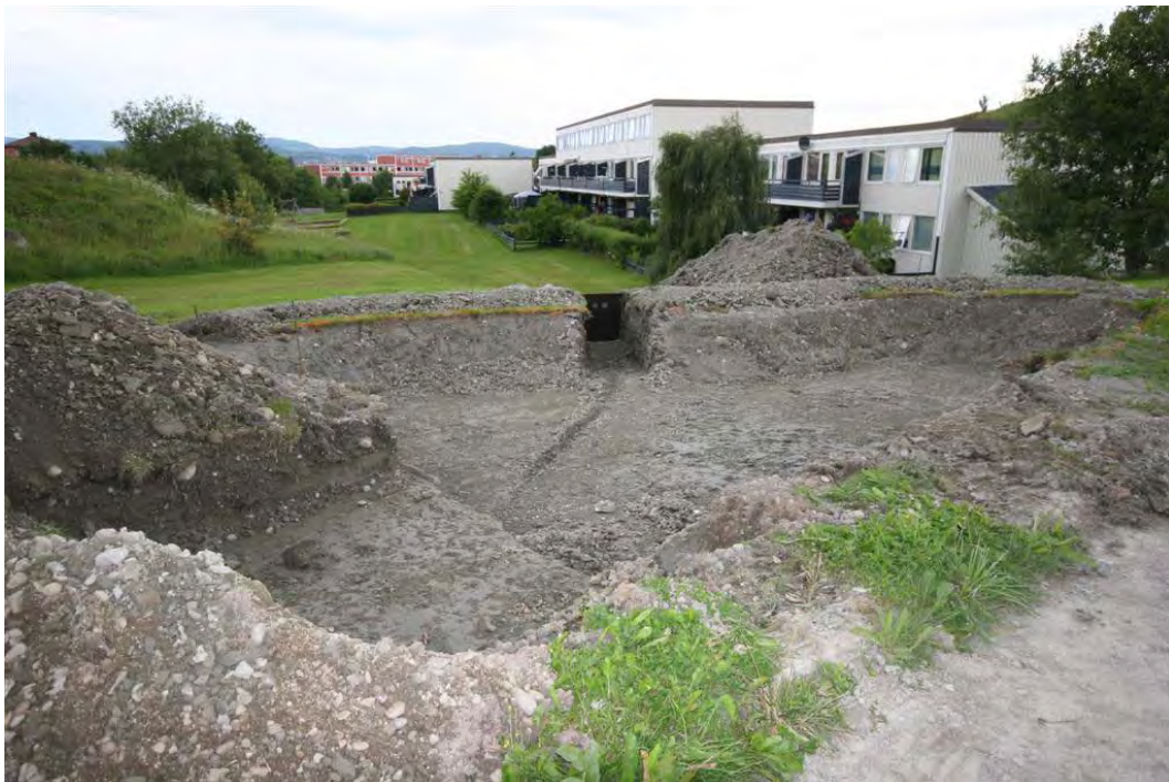
Figur 41. Regbedet er ferdig utgravet. Innløpet er til venstre og drenerør legges i grøfta midt i bildet. Filterdybden er planlagt til ca 0,75 m (foto: AE).
