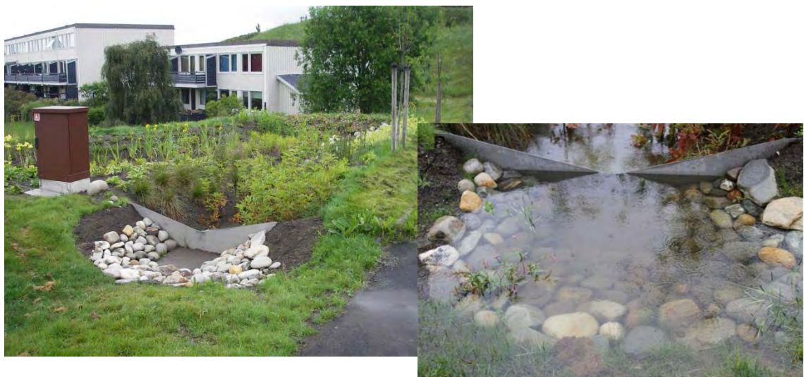
Figur 46. Måledammen ved innløpet. For å måle korrekt må det være en måledam forand V-overløpene (se vedlegg 9.4 for måling av vannstand i V-overløp). I nedbørfelt der tilførsel av partikler og søppel er sannsynlig, kan en forbehandling av vannet i et sedimentasjonskammer lette vedlikeholdet (foto: AE).
