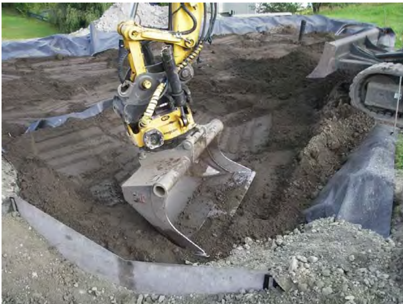
Figur 44. Filtermassene jevnes ut. For å unngå setninger pga. høyt porevolum og nedbryting av organisk materiale det første året, ble massen presset litt sammen med gravemaskinskuffa. Det må ikke gjentas, fordi infiltrasjonskapasiteten avtar drastisk! I store anlegg kan anleggning ett år, og planting året etter være det beste alternativet.
