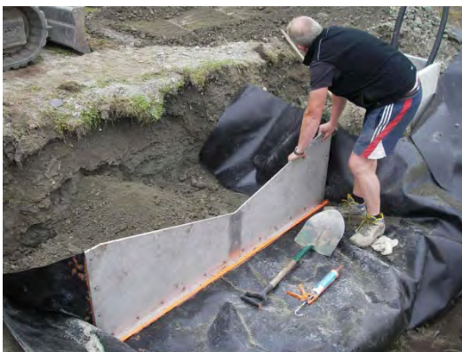
Figur 43. Montering av V-overløp inn og ut av regnbedet for å måle vannføring inn og eventuelle overløp. Deretter ble filtermasse bestående av kompostblandet sandjord fylt inn.
