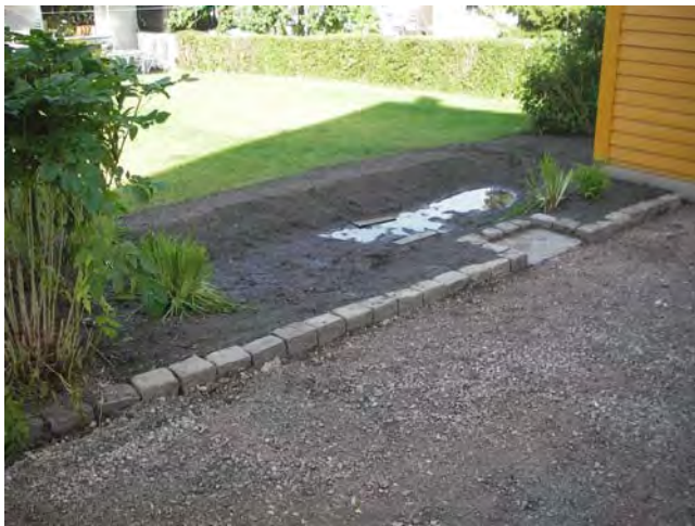
Figur 9. Ferdig utgravd regnbed. Anlegget ligger svært nær garasjen, men den høye infiltrasjonskapasiteten gir liten bekymring for skade på fundamentet. Etter 6 års drift har ingen skade skjedd. Vanligvis anbefales 1,5 m avstand til bygningsfundament og over 8 m til kjeller (PGC, 2007).
