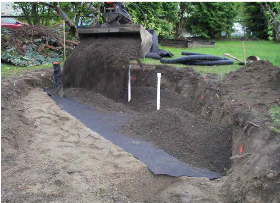
Figur 25. Fylling av filtermedium laget i figur 24.
