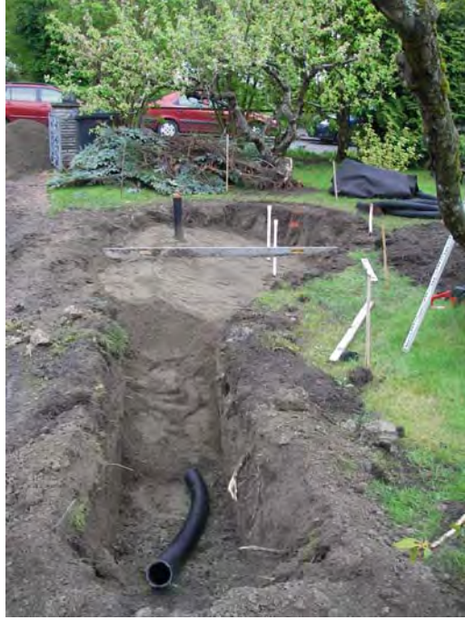
Figur 26. Regnbed NB21 med skråstilt drenslag i dagen og filtermedium (venstre bilde). Drensrør på 100 mm ledes fra regnbedoverflata og mot overvannskum (høyre bilde). Drensrøret var uten slisser (tett overflate) den første meteren, og lå ca 5-10 cm over bunnen på drenslaget, slik at jordfuktigheten ble forbedret i tørre perioder.
