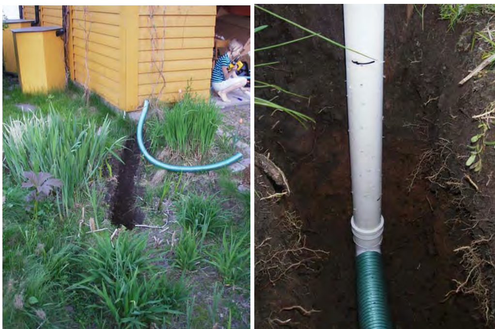
Figur 16. Grøft for tilkobling av markvannsrør (venstre). Gjennomboret markvannsrør til ca 10 cm under regnbedoverflata (høyre). Røret er også gjennomboret ca 2 cm over overflata og opp. Trykksensor (4tech) ligger i overgangen mellom markvannsrøret og det grønne tilførselsrøret. Sensoren ligger ca 52 cm under regnbedoverflata, og måler både vannstand i regnbedfilteret, på overflata og eventuelt overløp ut av regnbedet.
