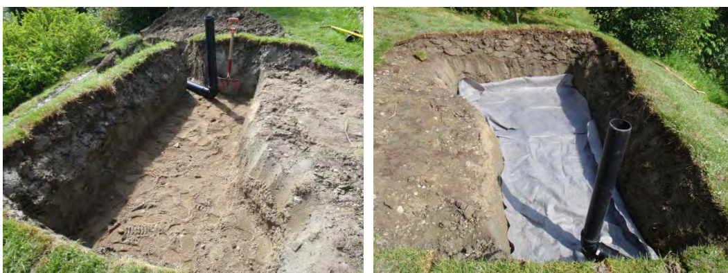
Figur 34. Drenslag i sand er lagt over drensørret (venstre foto). Fiberduk legges som massesperre for filtermediet (høyre foto). Styrt nedløpsør er satt på plass for håndtering av vannmengder som overstiger regnbedets kapasitet (foto: RAG).
