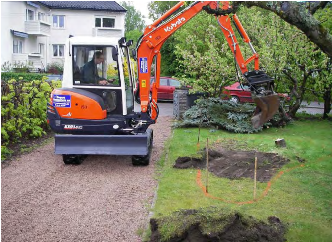
Figur 20. Regnbedets størrelse er markert og plen med røtter skrapes av. Jorda under er leirholdig, men med meget god kvalitet (grynstruktur). Vi ønsker å blande 5 % av denne inn i filtermediet seinere.
