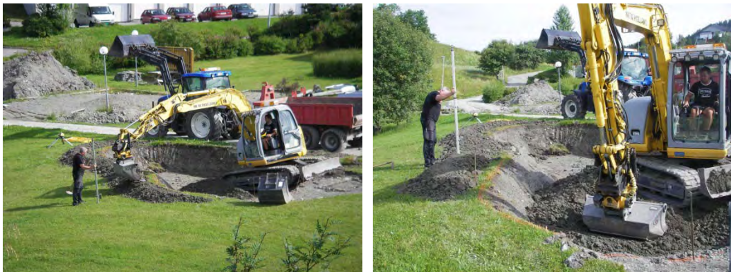
Figur 40. Utskifting av stedegen masse var nødvendig fordi leirjord har lav infiltrasjonskapasitet. Bremmen blir laget med en kjerne av stedegne masser.
