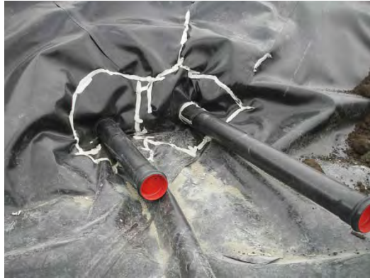
Figur 42. Tett membran legges i for å hindre evt. grunnvannstilsig til anlegget (NB! kun aktuelt der forskning skal utføres). To drenerør leder vann ut av anlegget.
