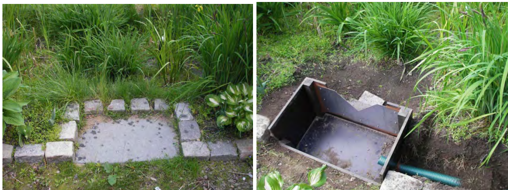
Figur 15. Skiferhella i innløpet ble skiftet ut med en vannfast kasse med 90 graders V-overløp. Trykksensor (4tech) ligger i det grønne røret. En varmekabel holder rør og kasse frostfri (enda ikke montert på bildet).
