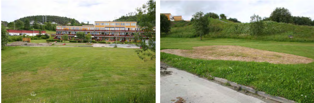
Figur 39. Før anlegging (venstre bilde tatt fra åsen i høyre bilde). Gras ble kjemisk bekjempet et par uker før anlegging for å unngå at rotugras skulle etablere seg. I tillegg letter det iblanding av stedegen toppjord i filtermediet der det er ønskelig (foto: AE).
