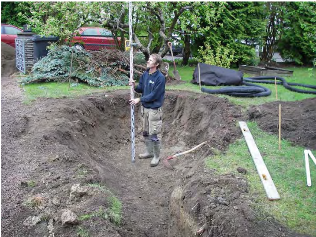
Figur 21. Regnbedet er gravd ut i ca 1 meters dybde. Grøft til rør fra taknedløp til regnbed, og med returvann via drenering til kommunalt nett er også ferdigstilt.
