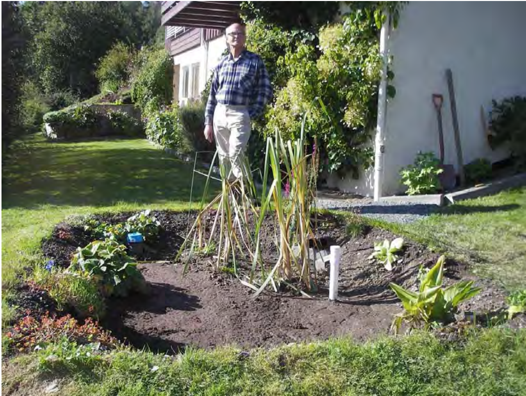
Figur 36. Rolf Grande har startet beplantningen i 2009. Dunkjevla sentralt i bildet trivdes ikke og ble byttet ut. Legg merke til styrtnedløpsrør med perforert, blått lokk i venstre hjørne. To takrennedløp ledes inn i regnbedet fra motsatte hjørne.
