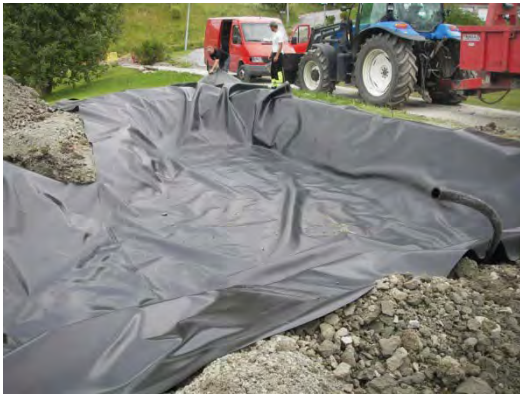
Figur 42. Tett membran legges i for å hindre evt. grunnvannstilsig til anlegget (NB! kun aktuelt der forskning skal utføres). To drenerør leder vann ut av anlegget.
