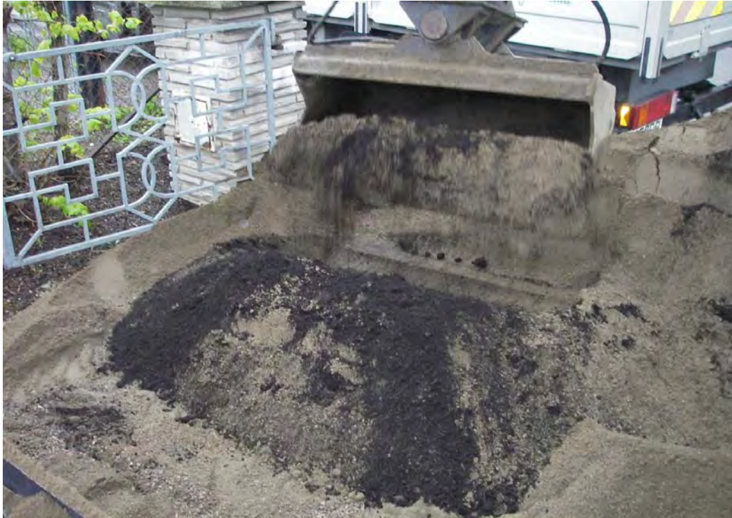
Figur 24. Filtermedium ble laget av sand av samme type som ble brukt i drensaget (ca 50 %), blandet med Oslokompost® (50 % hageavfall og 50% sand) og ca 5 % stedegen hagejord av god kvalitet. Vi kunne kanskje ha økt andelen Oslokompost noe mer i forhold til sand for å gi plantene enda bedre vekstforhold?
