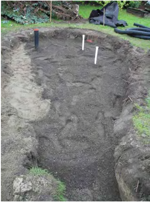
Figur 26. Regnbed NB21 med skråstilt drenslag i dagen og filtermedium (venstre bilde). Drensrør på 100 mm ledes fra regnbedoverflata og mot overvannskum (høyre bilde). Drensrøret var uten slisser (tett overflate) den første meteren, og lå ca 5-10 cm over bunnen på drenslaget, slik at jordfuktigheten ble forbedret i tørre perioder.
