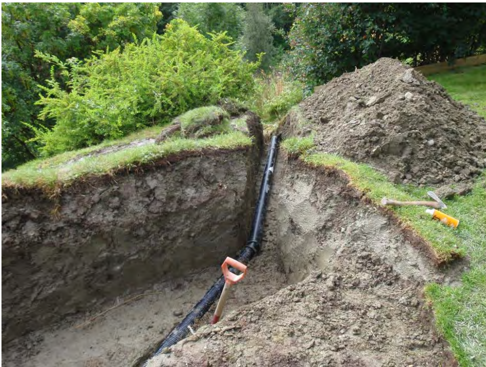
Figur 32. Plenen fjernes der regnbedet skal anlegges. En vid grøft graves for drenerør og filtermedium (foto: RAG).
