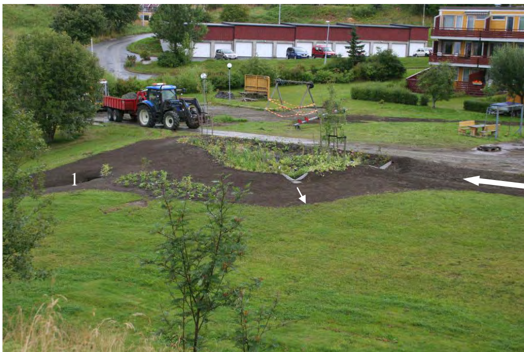
Figur 56. Regnbødet på Risvollan ferdig anlagt med vadi som leder vann til V-overløp inn, overløp og måling av drenevasn (1). Foto: AE.
