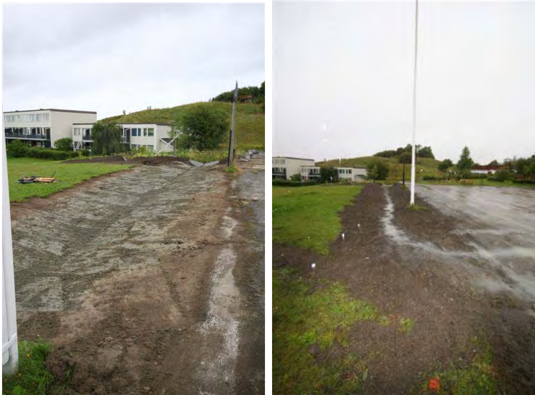
Figur 54. Vadi formet i terrenget slik at maskinell gressklipping er mulig. Et tynt dekke med kompostholdig sandjord (det samme som i filtermediet) ble lagt som toppdekke og tilsådd med gress.
