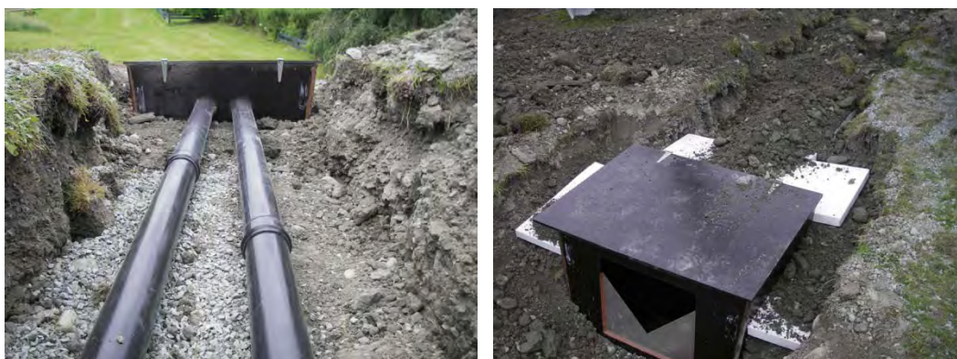
Figur 49. Vannet fra to dreisrør ledes til kasse med 90 graders V-overløp.
