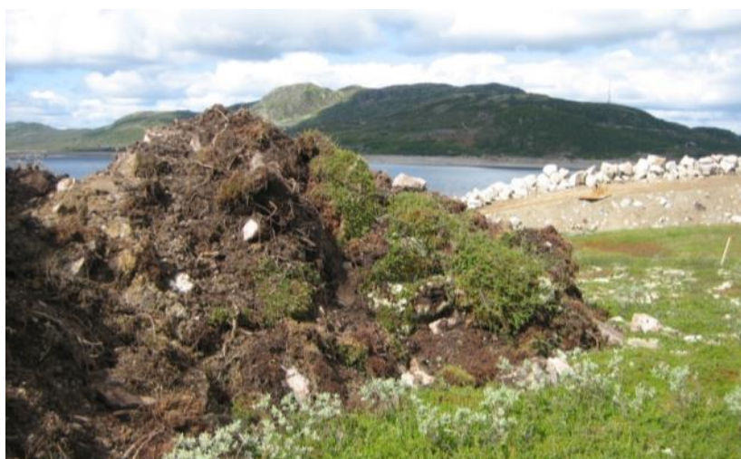
Mellomlagring av toppjord med intakte vegetasjonsflak i anleggsfasen ved Skagerak Krafts rehabilitering av vannkraftdam Sønstevatn, Imingfjell. En del slike vegetasjonsflak kan forventes å overleve ved skånsom tilbakelegging. Foto: Per Anker Pedersen.
