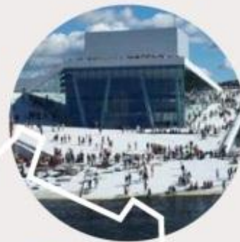
BJØRVIKA Du kommer til den kompakte byen. Vil utvikles til en knutepunktkontekst, der de første ikonene (Barocde, Operaen etc.) vil fornes ned etter hvert som flere bygg kommer opp.
