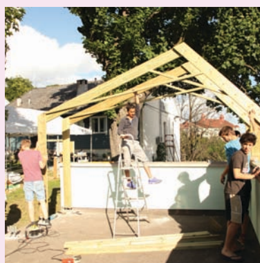
BYGGING av ute paviljongen @Torshov transittmottak Juli 2016
