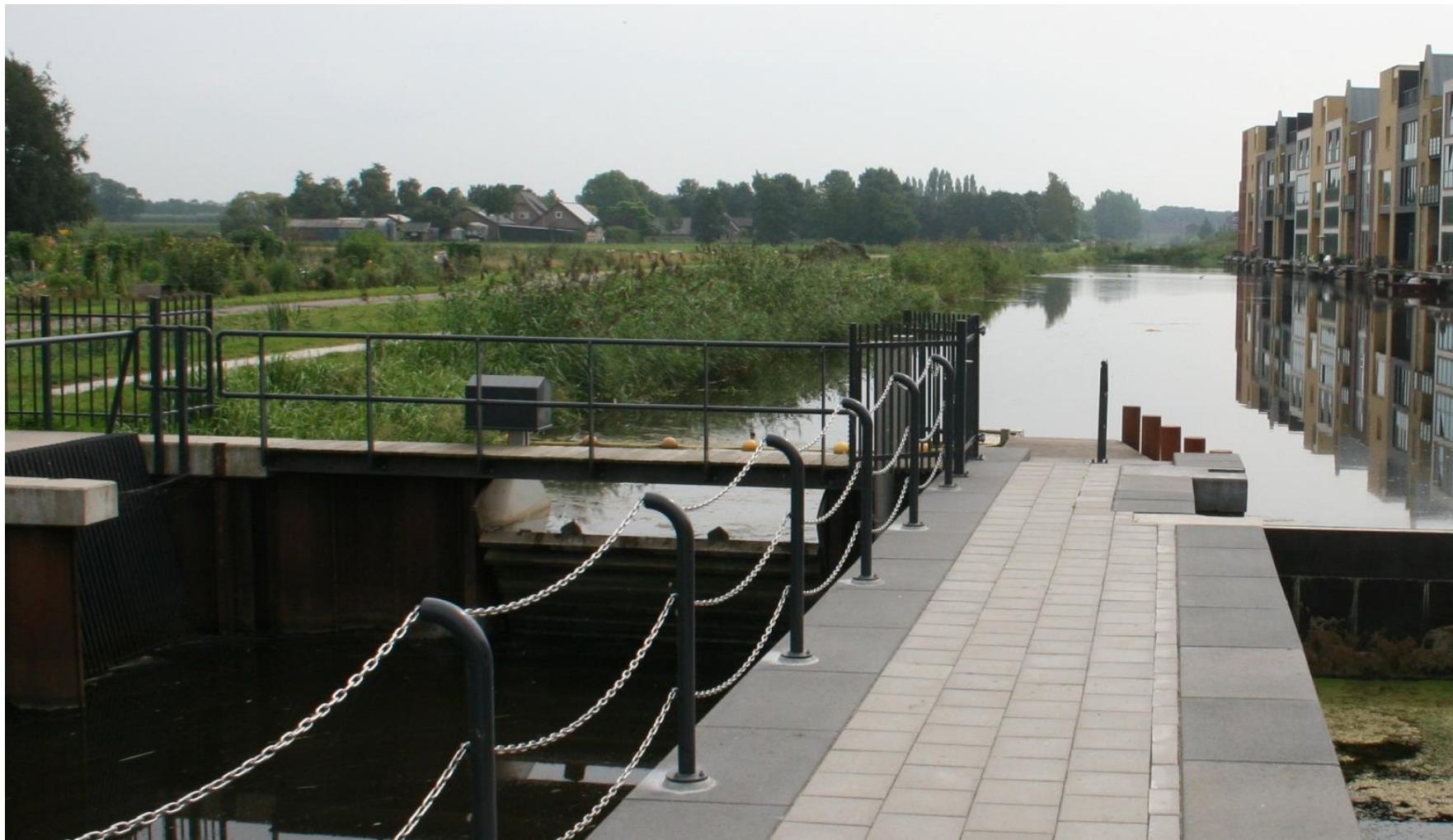
Smart polder: energie uit de polder
