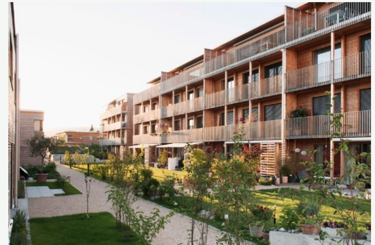
Pilotprosjekt eksempel: Boligområdet «Sunny Watt», Sveits, arkitekt Beat Kämpfen-Federer. Planlagt for både sosial, miljømessig og økonomisk bærekraft. Massivhusprosjekt og tilnærmet null-energihus. Består av prefabrikerte tak og vegger. Kombinerer bruk av solenergi og geotermisk energi.
