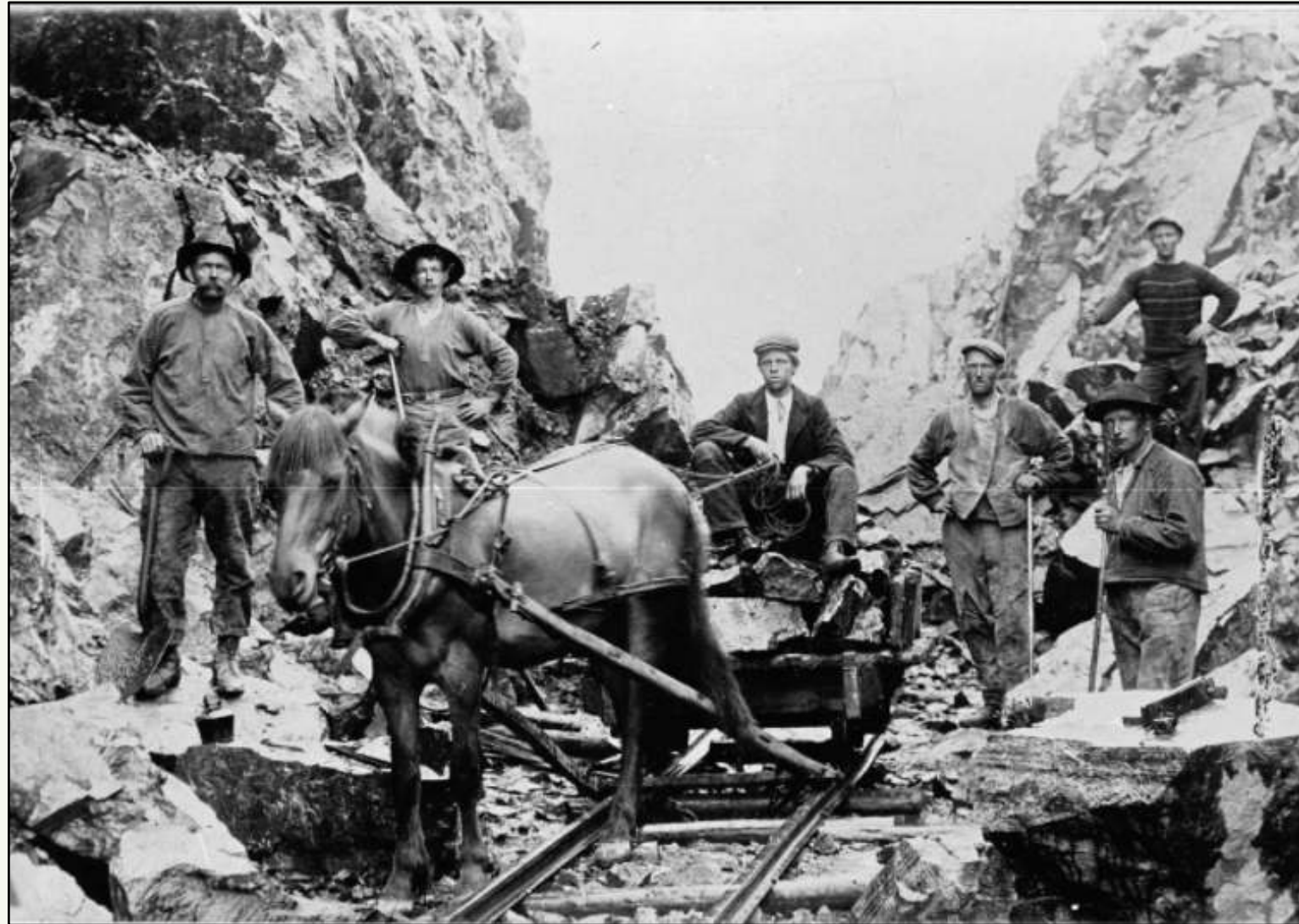
Bygging av Bergensbanen
