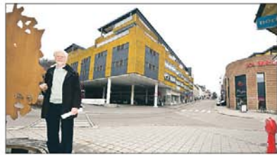
Elementær ABC: Arkitekt Butenschøn mener det er elementær ABC innenfor byplanlegging at man ikke skal ha fasader som knekker, som på det nyrestaurerte parkeringshuset. Det bryter fasadelinjen og skaper ubalanse i gatebildet.
