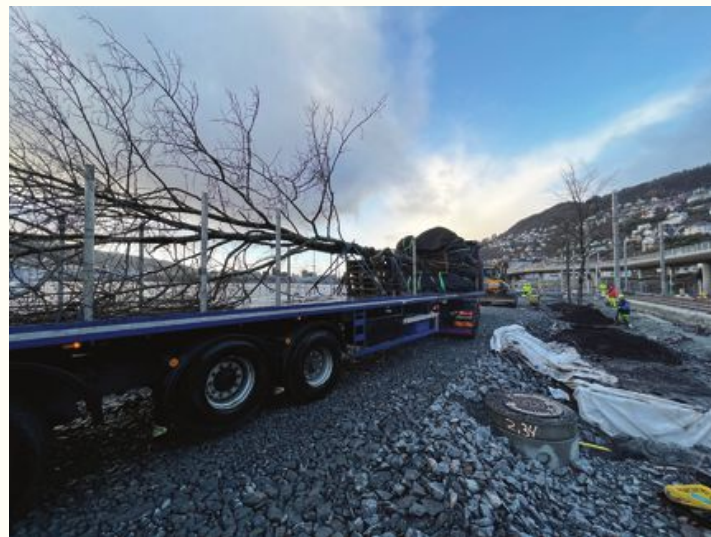
Mye må klaffe når trærne skal transporteres: Liggende på lastebilen kan ikke kronen overstige maksbredden man kan frakte langs veien. Samtidig må det være likevekt mellom kronen og rotsonen. Foto Camilla Einarsen Heggernes
