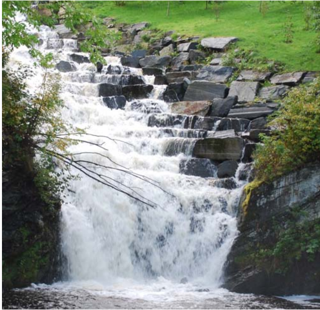
Ilabekken. Foto: Statens vegvesen
